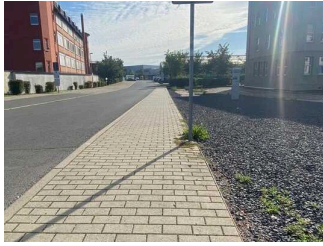
Weg vom Haupteingang zum Nebeneingang (barrierefrei)
