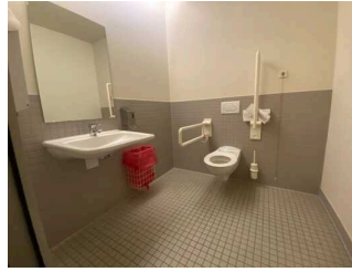
Blick zum WC und Waschbecken
