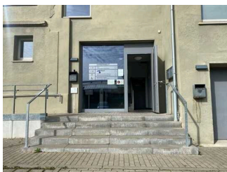
Treppe zum Nebeneingang
