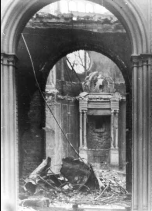
Der zerstörte Toraschrein in der Großen Synagoge Erfurt nach der Pogromnacht 9./10. November 1933 Stadtarchiv Erfurt
